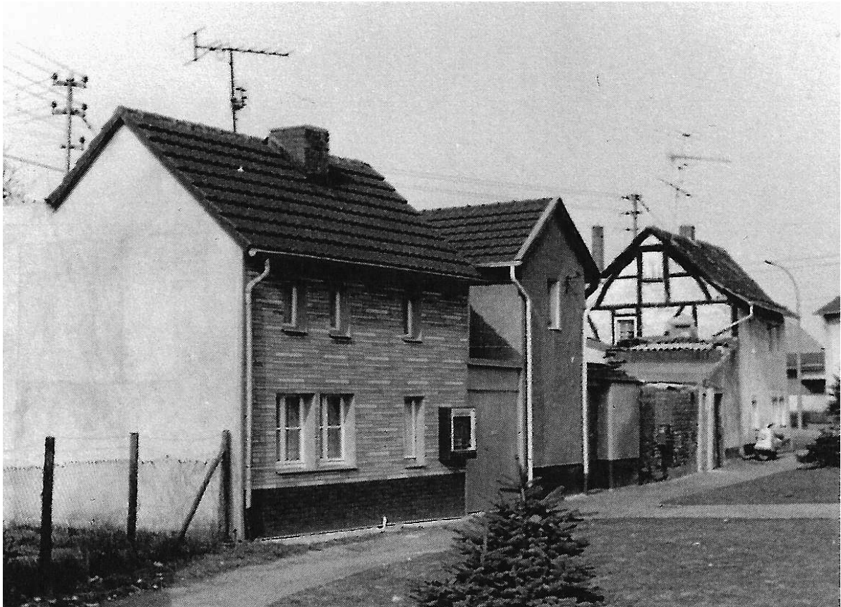
Abb. 9: Kleine Wohnhäuser am südöstlichen Dorfrand aus der Mitte des 19. Jh. Es handelt sich um Fachwerkbauten, die heute z.T. verputzt und verkleidet sind.
